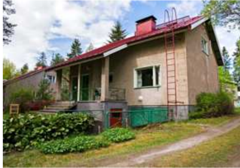
Anita ja Antti Koskinen ovat remontoineet 1950-luvulla rakennettua omakotitaloa vanhaa kunnioittaen. Työsarkkaa riittää yhä.
