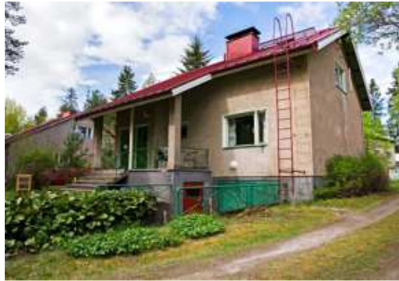
Anita ja Antti Koskinen ovat remontoineet 1950-luvulla rakennettua omakotitaloa vanhaa kunnioittaen. Työsarkaa riittää yhä.
