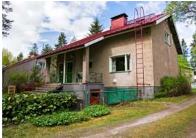
Anita och Antti Koskinen har renoverat 1950-talshuset med respekt för det gamla. Fortfarande finns en hel del kvar att göra..
