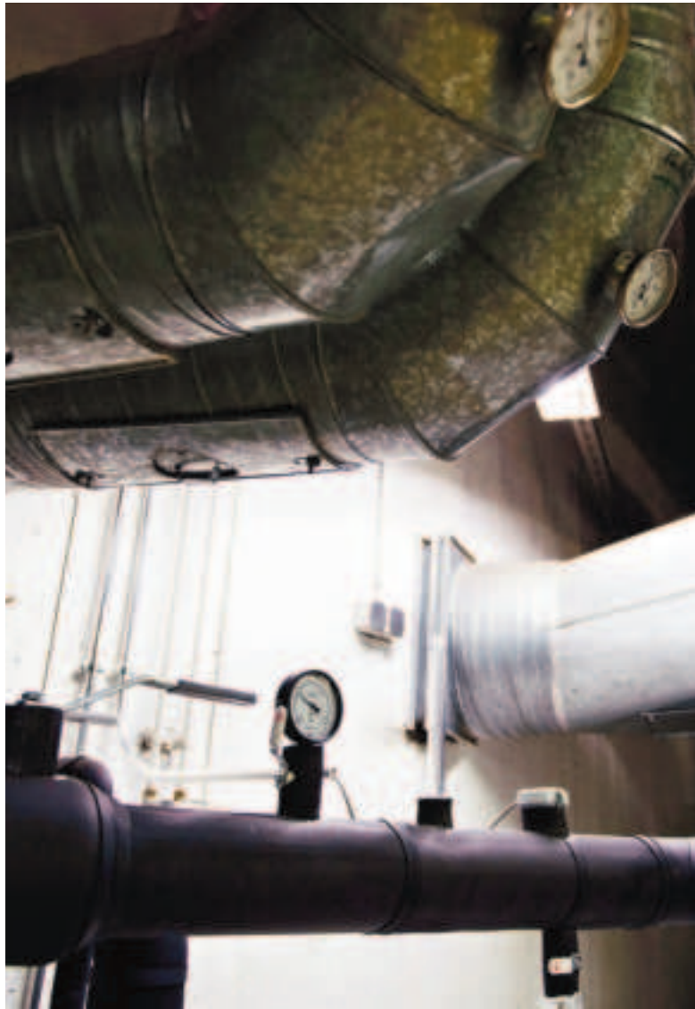
Kaukojäähdytysputket asennettiin Strandiin vuonna 2014. Laitteisto vie vain vähän tilaa.
