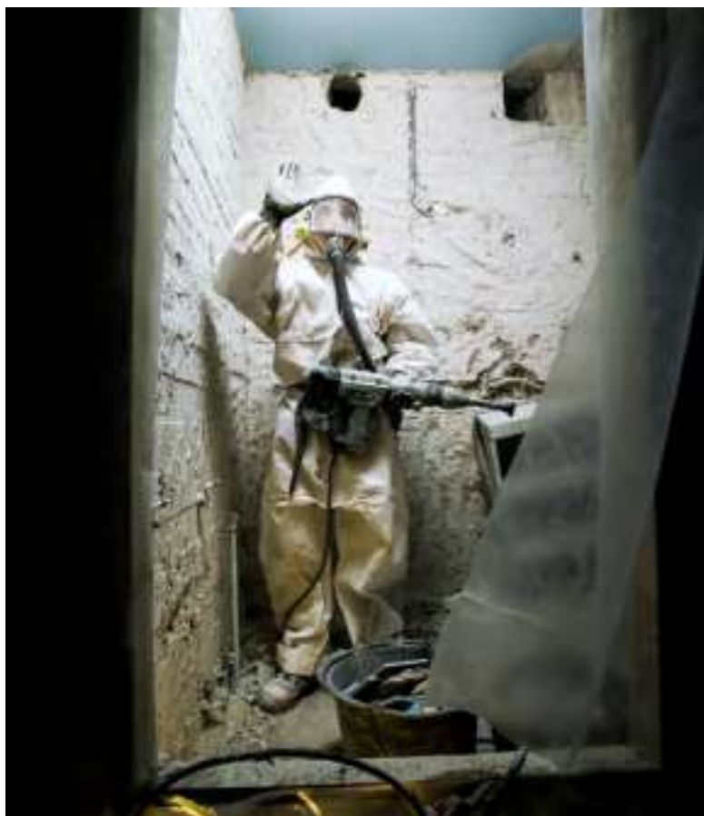
Rakenteiden purkutöissä pölyä, mutta kunnon varusteissa se ei haittaa.
