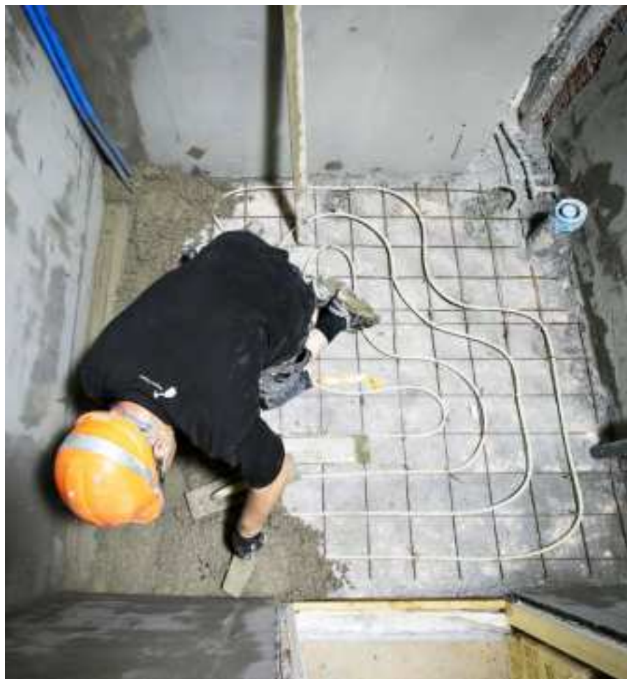
Mukava lämpö jalan alle. Lattiavalu tehdään lämmitysputkien päälle.
