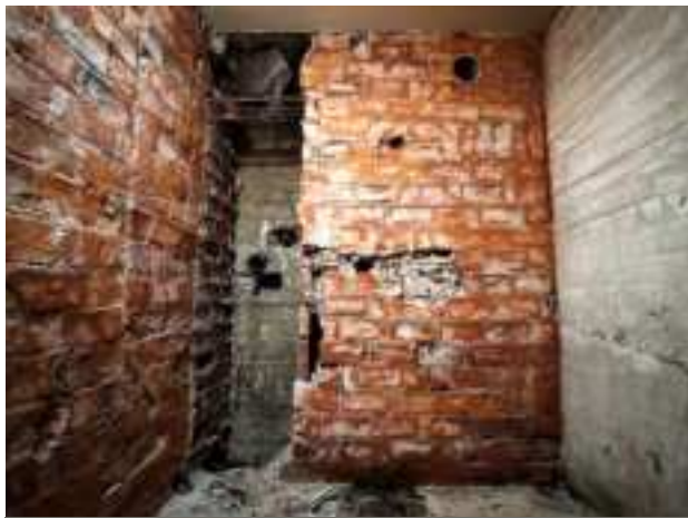
Plats för nytt. Alla ytkonstruktioner har rivits.
