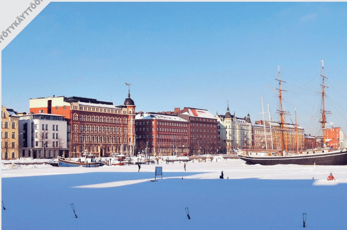
Kruununhaan lisäksi lämmöntalteenottojärjestelmä on käytössä viidellä muullakin Helen Sähkönverkon sähköasemalla.
