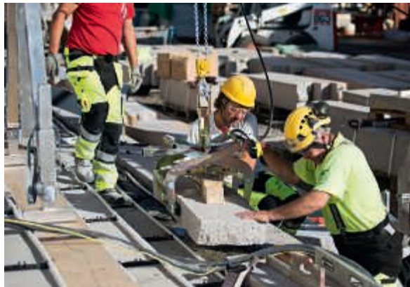
Eduskuntatalon portaat purettiin, ja niiden alle asennettiin kaukolämmöllä toimiva sulanapitojärjestelmä sekä betoniperusta. Jokainen kivilankku merkittiin ja palautettiin uudelleenmuotoilun jälkeen paikoilleen.
