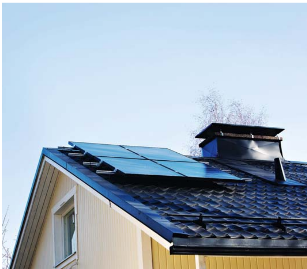
På Veikko Holmströms tak finns ett solelssystem på 1 kWp med fyra paneler.
