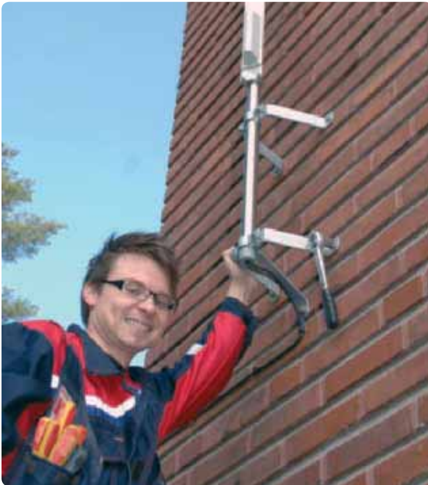
Ville Pirhonen Mitox Oy:stä tekee etäluentasennuksia Pakilan-Paloheinän alueella.
