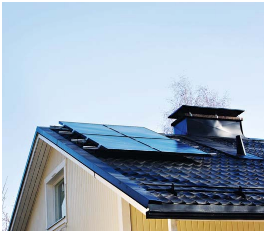
Veikko Holmströmin katolla on 1 kWp:n eli neljän paneelin aurinkosähköjärjestelmä.
